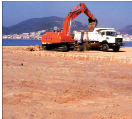
Photo b - Décapage de la terre recouvrant le sable du terre-plein (2001). (Photo F. GALLERAS, Cdl).
