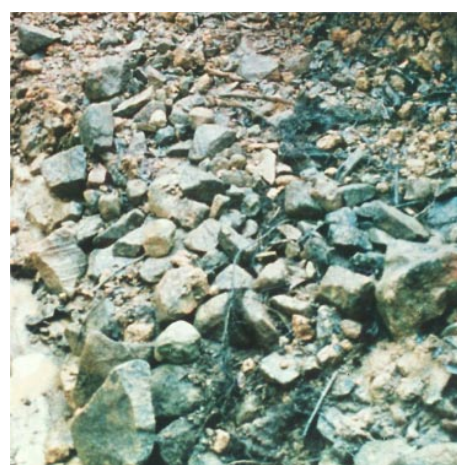
▲ SURFACE D'UN ANCIEN BARANQUE APRÈS COMBLEMENT ET TERRASSEMENT ; LE RÉGILAGE A POUR CONSÉQUENCE UN COMPACTAGE DES SUBSTRATS
