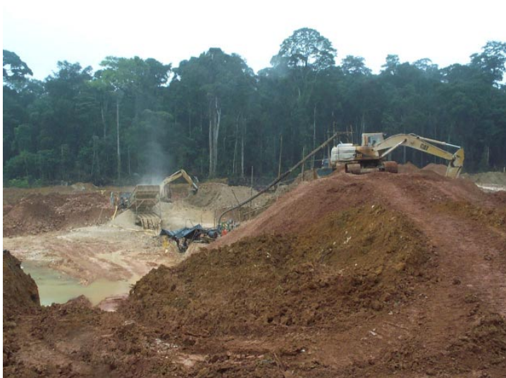
▲ EXCAVATION EN COURS ET EXPLOITATION DES COUCHES ALLUVIONNAIRES "MINÉRALISÉES"
