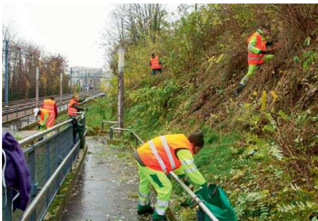
Travail sur talus sec de voies ferrées.
